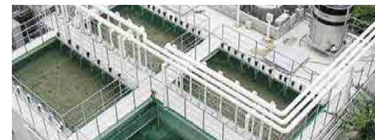
水処理プラント 排水処理
